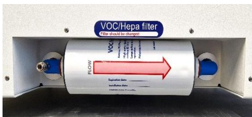
Afbeelding 12.3 Correct geïnstalleerd VOS/HEPA-filter
